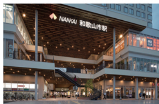
第5回 佳作「きのくに県民館・紀州材賞「キノノ和歌山」」 建築主：南海電気鉄道株式会社 設計：株式会社アル・アイ・エー大阪支社 施工：竹中工務店・南海辰村建設・浅川組共同企業体
