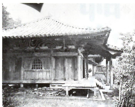
薬師堂 修理前
