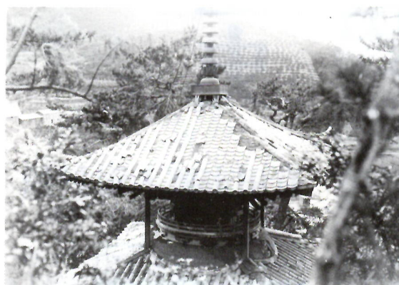
多宝塔 修理前
