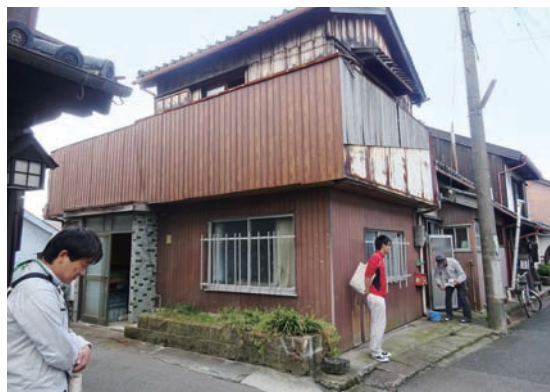
見矢家住宅現場調査
